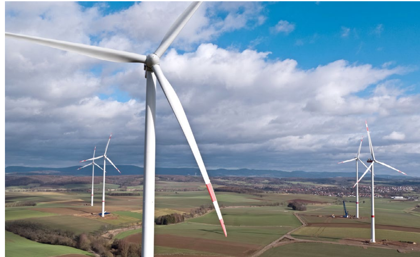
Windpark Gieboldehausen (28,5 MW, Deutschland)
