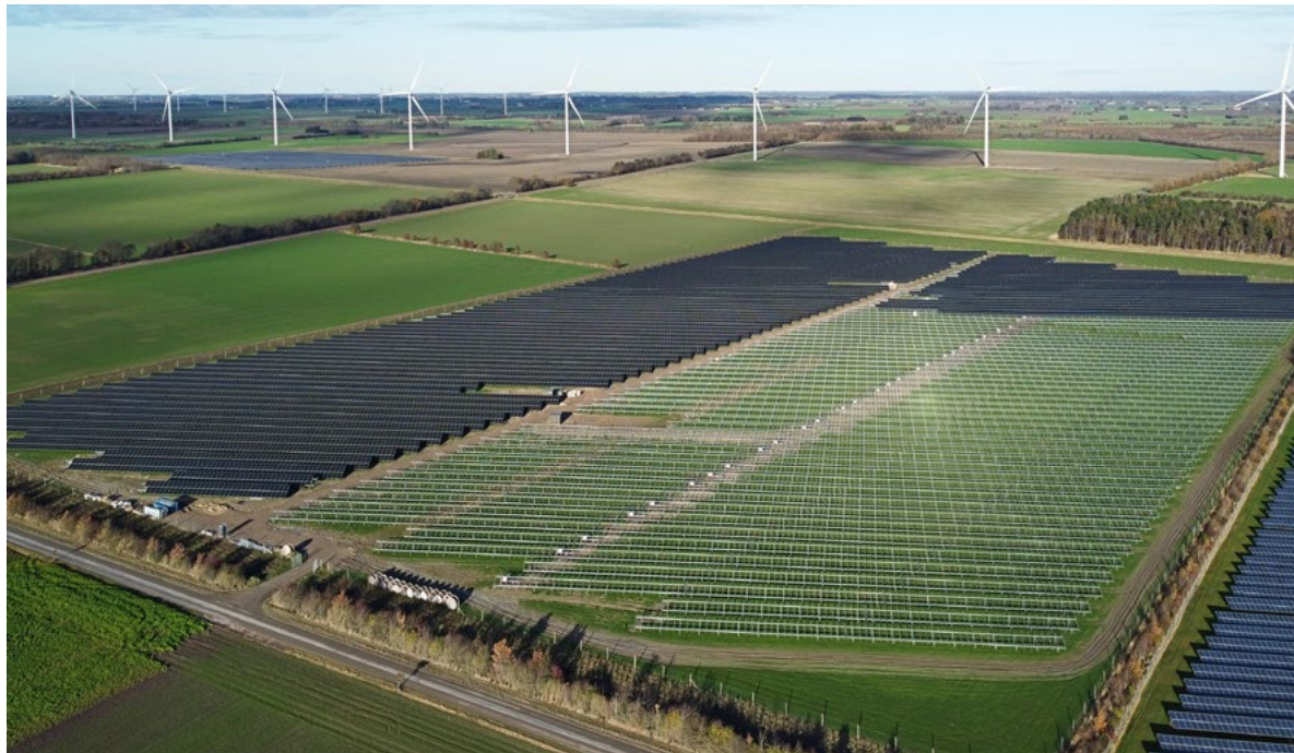
Solarpark Rodby Fjord (71,4 MWp, Dänemark)
