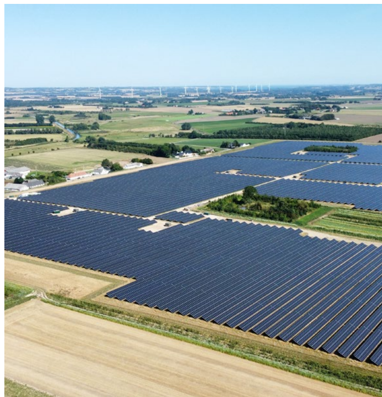
Solarpark Svinningegården (33,9 MWp, Dänemark)
